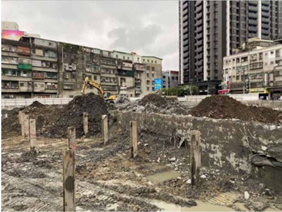
第一層土方開挖(含鋪面)
