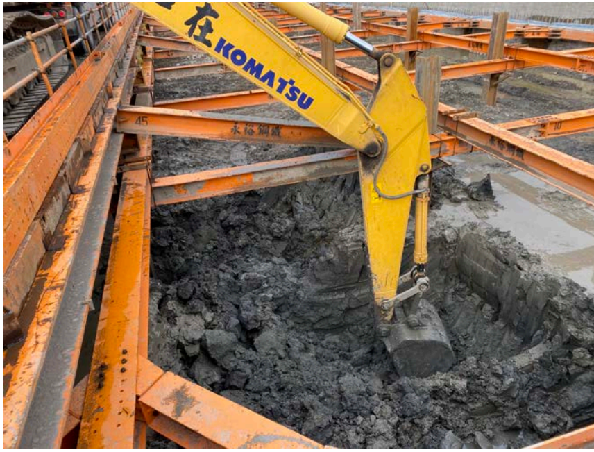
第二層土方開挖
