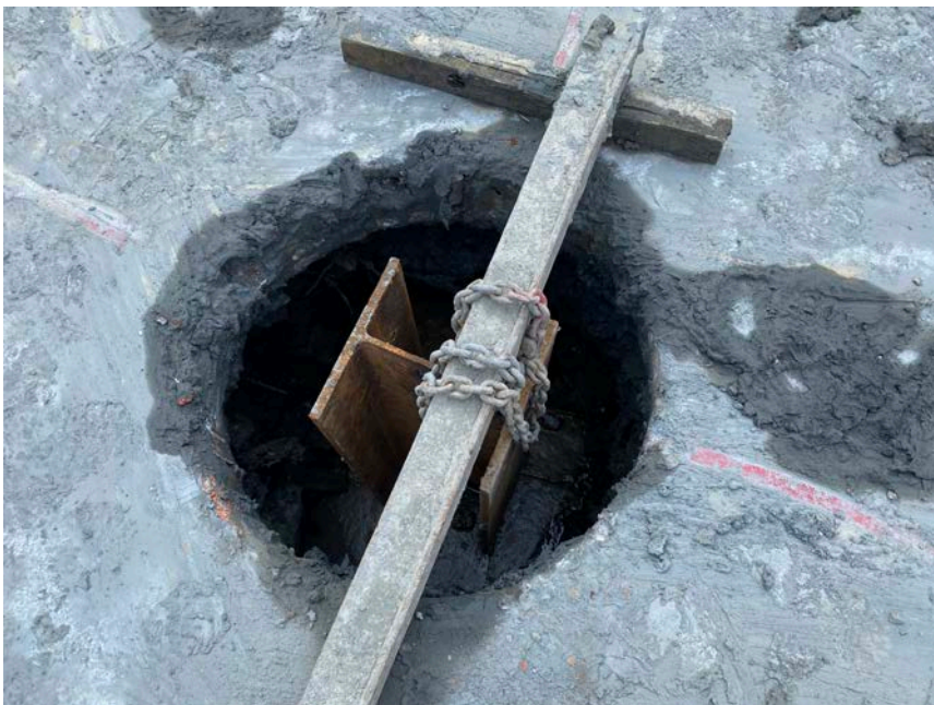
引孔根固施作
