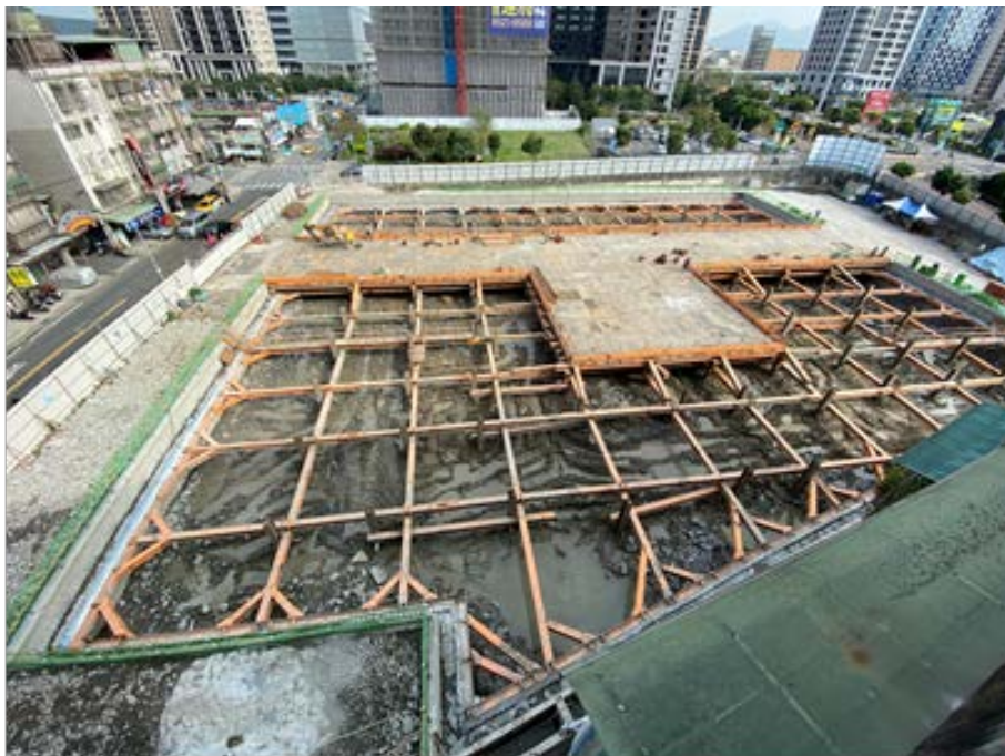
第一層土方開挖(含鋪面)
